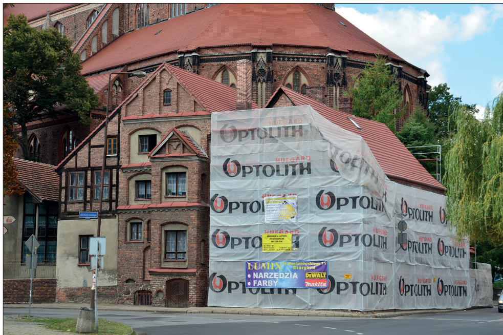
Ryc. 5. Remontowany budynek plebanii kościoła Mariackiego, wg stanu z 5 września 2013 r. Fot. A. Bierca, MAH w Stargardzie
